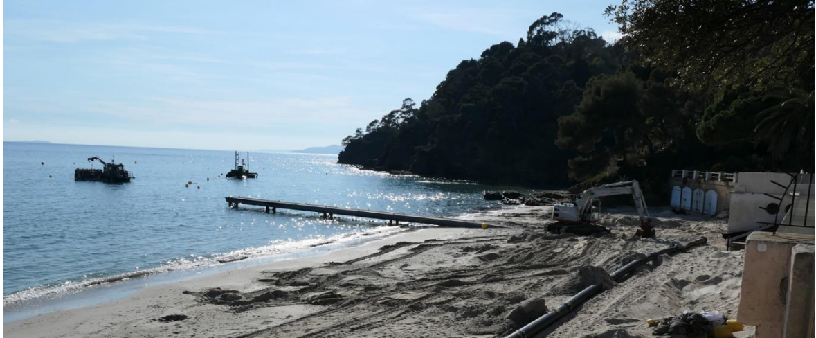
Vue des travaux de la plage ouest du Rayol
