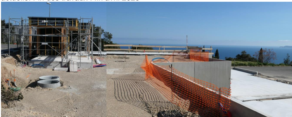
Le quai de déchargement, la zone des bennes en contrebas
